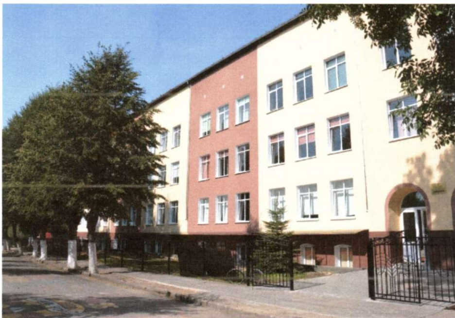
Фото 9. Школа после ремонта.
